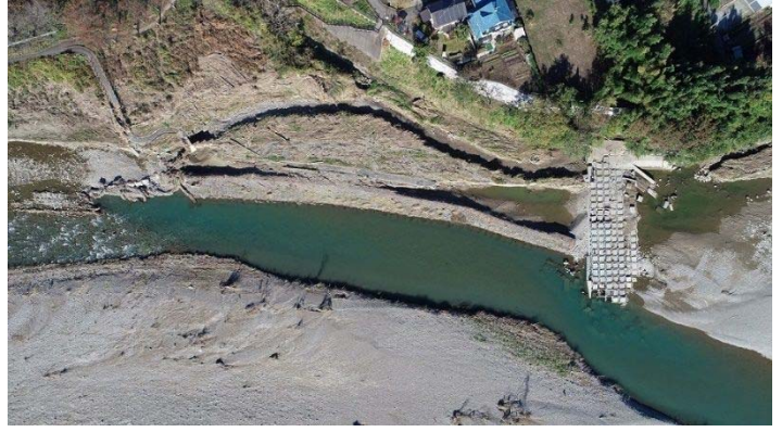
台風19号 堰の損壊(あきる野市)
