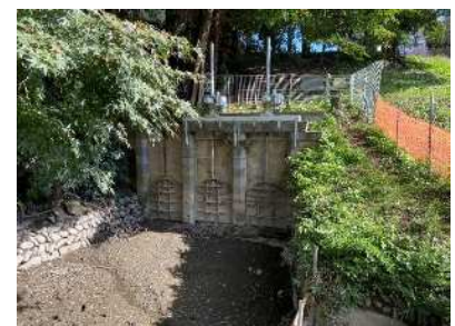
府中用水取水樋門(多摩川左岸)
