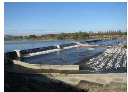
大丸用水頭首工(多摩川右岸)
