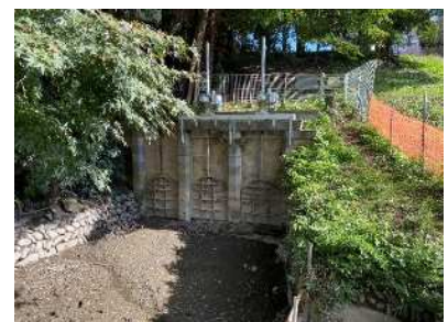
府中用水取水樋門(多摩川左岸)
