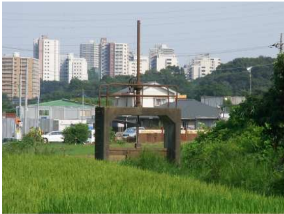
農業水利施設の例（取水施設）
