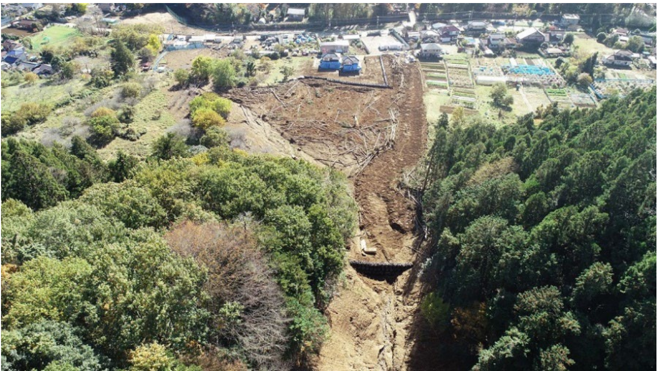
台風19号 農地への土砂流入（八王子市）
