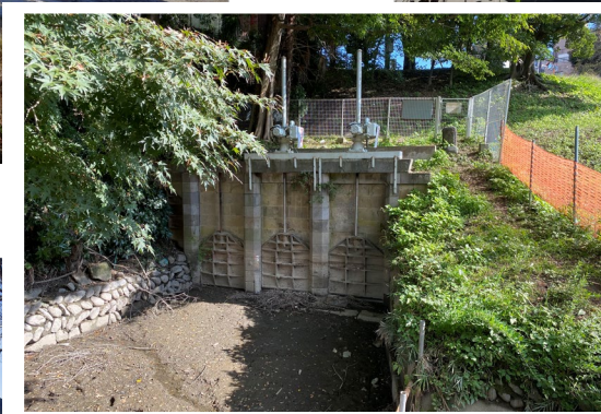
▲府中用水樋門
