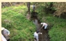
水路の泥上げ
