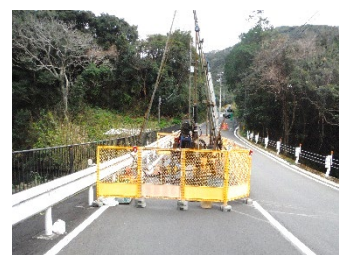
周辺のボーリング調査
