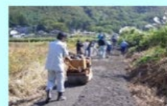
土砂道の補修
