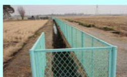
安全施設の整備
