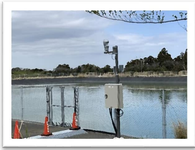
貯水池の遠隔監視カメラ・大島町
