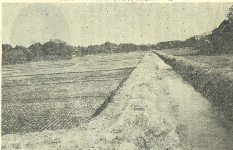
完成せる石神井土地改良事業地区の一部
