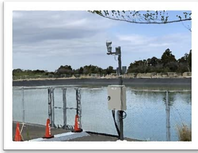
貯水池の遠隔監視カメラ・大島町
