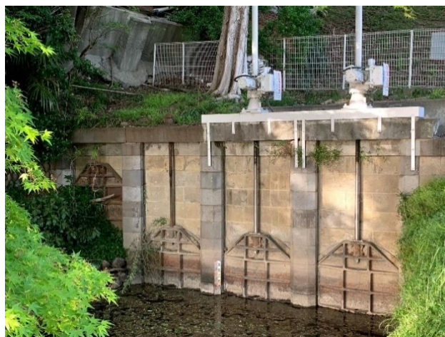
府中用水樋門（多摩川からの取水口）
