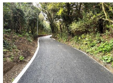
アスファルト舗装された農道
