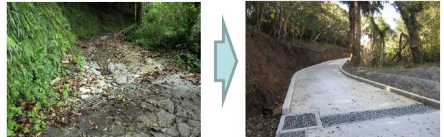
農道整備（八丈町 中之郷安川地区）
